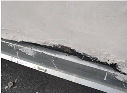
***Примыкание фартука к стене вентиляционного канала не обработано герметиком*** - затекание дождевых и талых вод.
