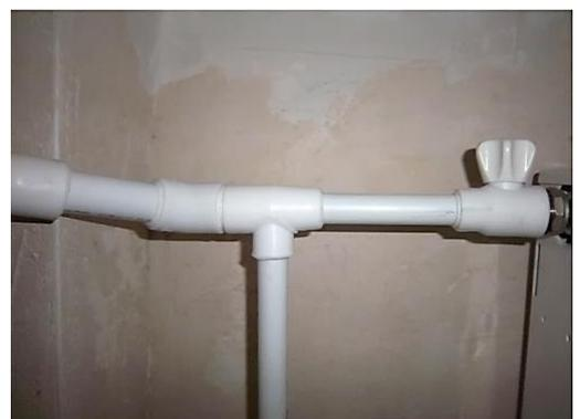
**Заужение диаметра подводки к отопительному прибору** - ухудшение проходимости теплоносителя, радиатор не прогревается.
