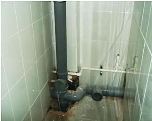
**Отсутствует гидроизоляция в перекрытии** - сложности в эксплуатации системы.
