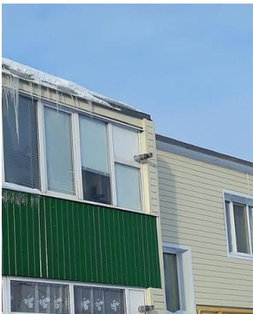
*Например, при капитальном ремонте многоквартирного дома не устроен слив с крыши балкона, соответственно дождевые и талые воды попадают между стеной дома и смонтированным фасадом дома, что в свою очередь приводит к намоканию стены и образованию плесени.*
