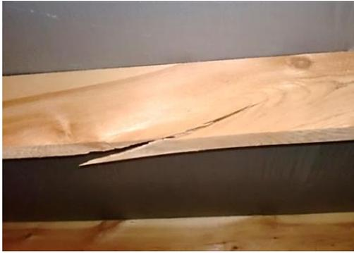
**Треснутая стропильная нога** - ослабление стропильной системы, обрушение кровельного покрытия.
