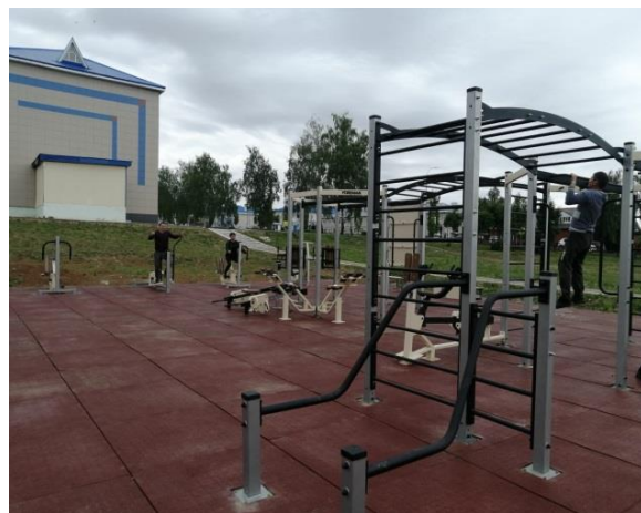
По итогам проверки Счетной палаты оборудование смонтировано
